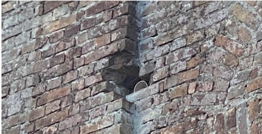
Caño de PVC perforando fachada sector vivienda
