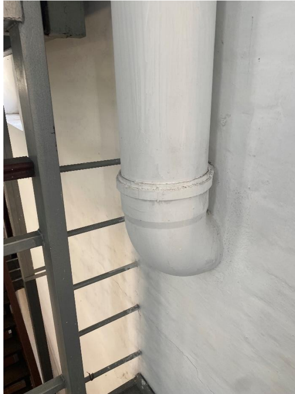
Columna de lluvia N° 5 donde se desvía para salir al exterior.
