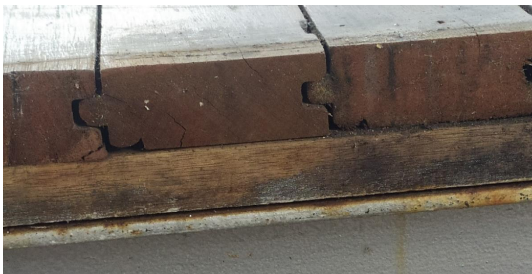
Relevamiento del piso, piezas, secciones, desniveles.
