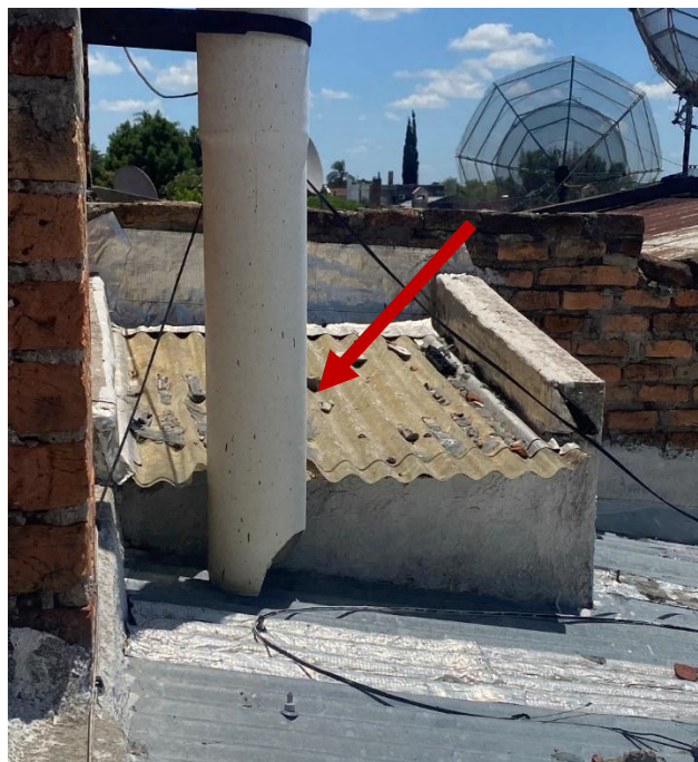
Columna de lluvia N° 7, que desvía en nivel 2 por el exterior y desagota en nivel 1 sobre cubierta 1
