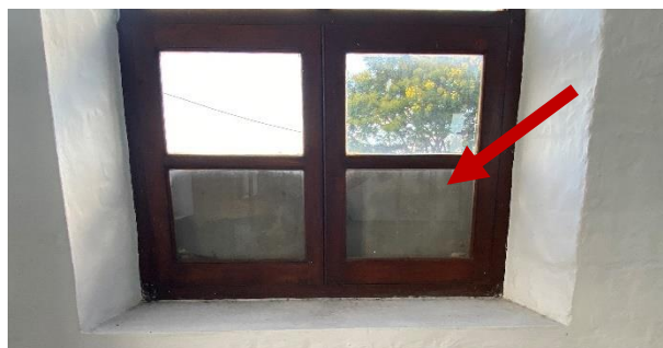
Muro realizado que genera muro trampa entre vidrio y abertura
