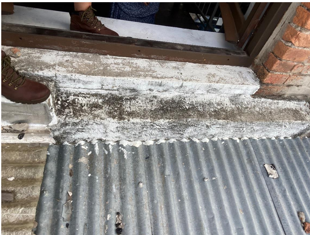
Remate de cubierta dos contra volumen principal (junto a ventana y lucernario)
