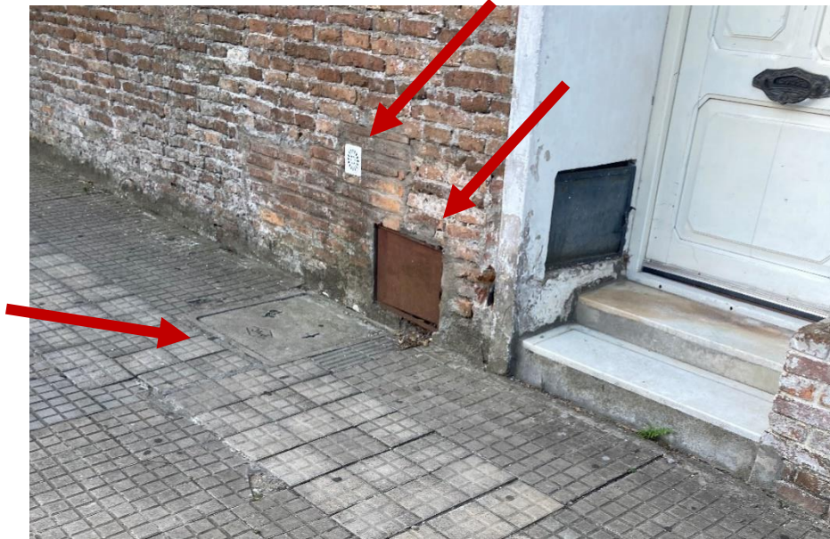
Contador de agua y cámara de pluviales en vereda con ventilación de las columnas de lluvia 1 y 2.
