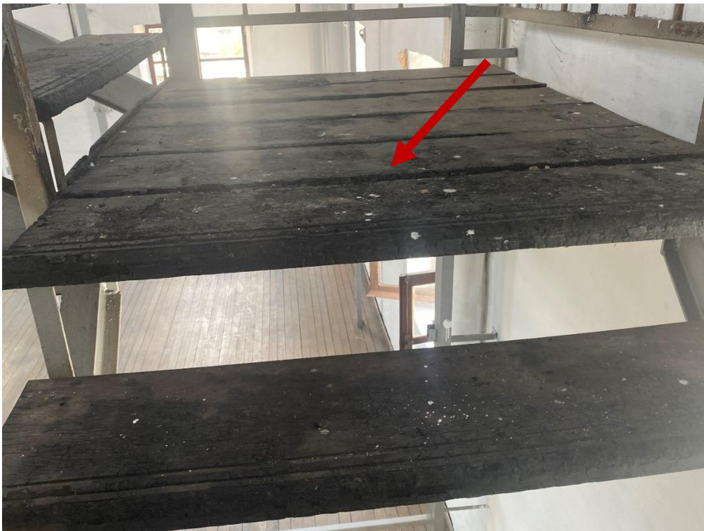
Vista de escalera dañada por el fuego (descanso y escalones)
