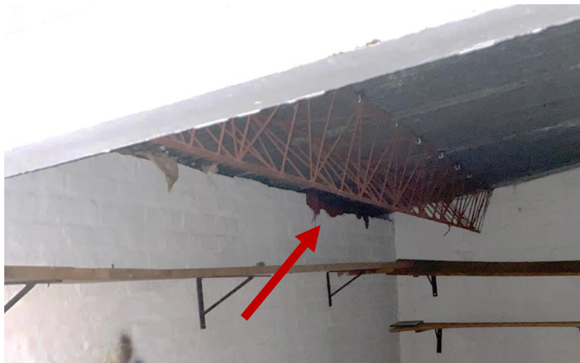
Plano D_02. Faltante de revoque y fisuras.
