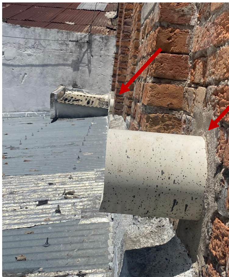
Columnas de lluvia N° 3 y 5 que desagotan en caída libre sobre cubierta 2
