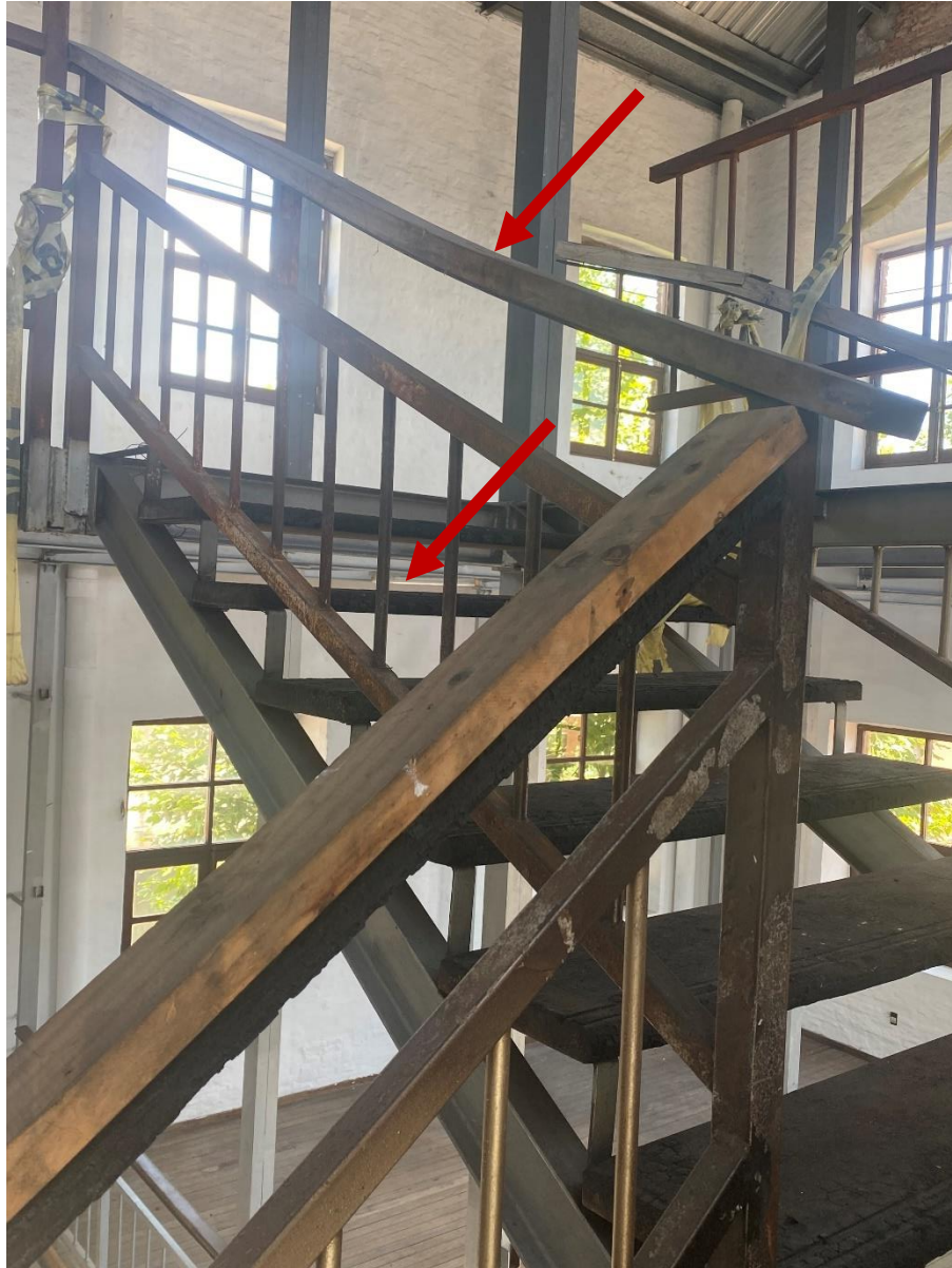
Vista de escalera dañada por el fuego (escalones, barandas)
