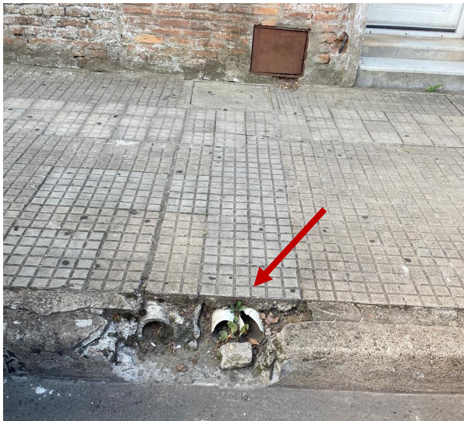
Cantidad y estado de la cañería de pluviales hacia cordón de vereda.
