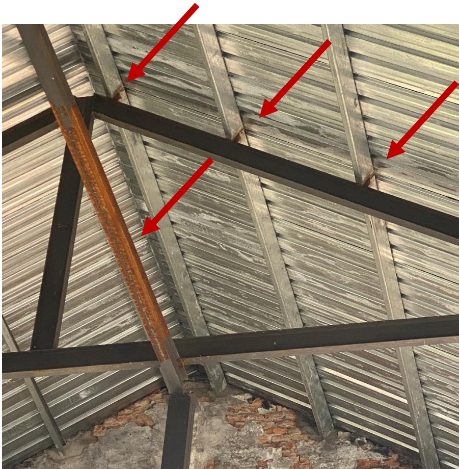
Cubierta 1. Todas las soldaduras de la estructura están para tratar, así como la estructura metálica de soporte
