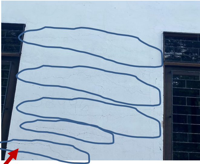
Fisuras a nivel de fachada fondo
