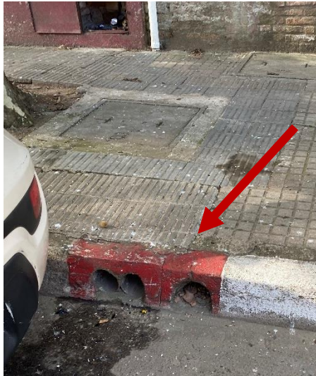
Desagüe de columna de lluvia 8. Cámara que recibe la columna 8. Ventilación asociada que no aplica a 40 cm de nivel de vereda.
