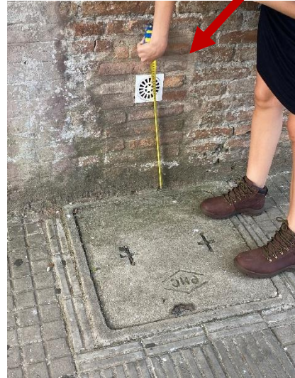
Desagüe de columna de lluvia 8. Cámara que recibe la columna 8. Ventilación asociada que no aplica a 40 cm de nivel de vereda.
