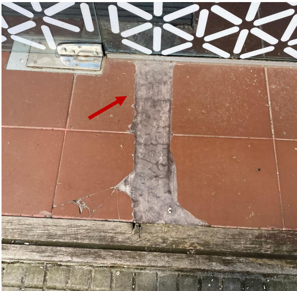
Acceso al edificio, umbral intervenido por desagüe.
